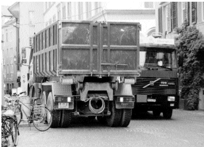
Die Baustelle sei erträglich, meinen die Nachbarn. Und doch wird es manchmal eng auf dem Kirchplatz, wie Figura zeigt.
