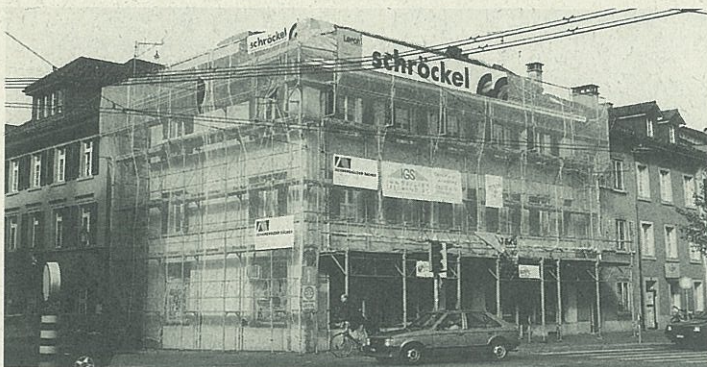
Ein neues Dach bekommt die Liegenschaft Ecke General Guisan-Strasse/Tösstalstrasse.
