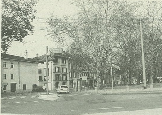
General Guisan-Strasse: Sanierung von St. Galler- bis Römerstrasse, 1994 1 Million, total 4,2 Millionen.
