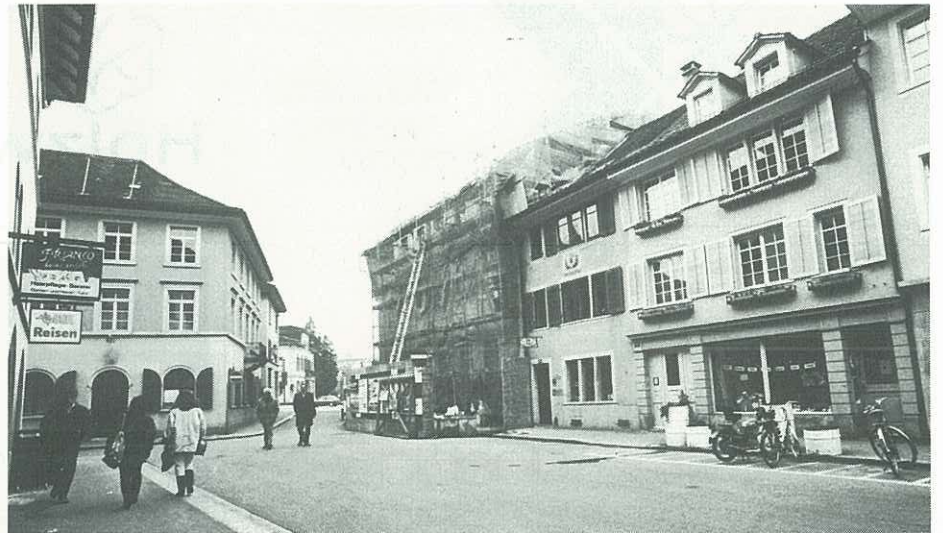
Tösstalstrasse 14 und Tiefenhof: Dachauf- und -ausbauten.
