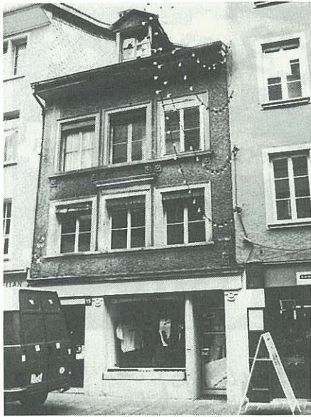
Untertor 15: Wiederaufbau, Wohn- und Geschäftshaus.
