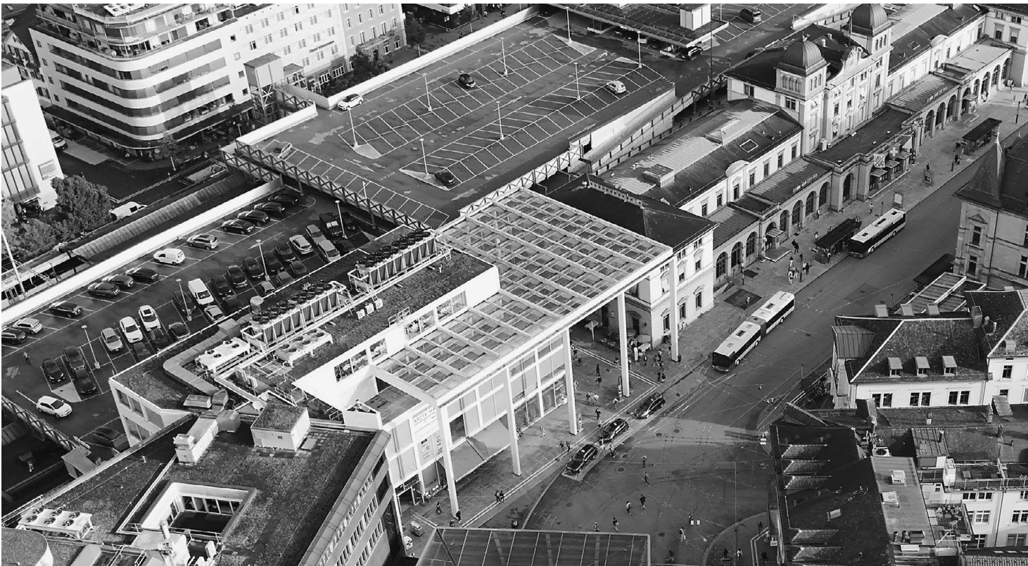
Hauptbahnhof / Bild: Stadt Winterthur
